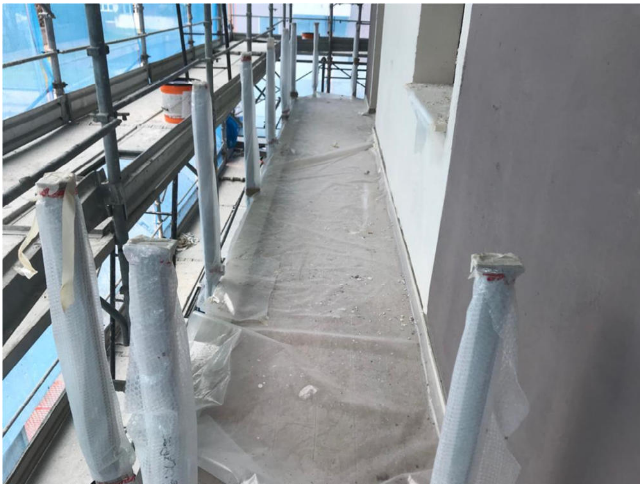
Dettaglio della posa in cantiere
