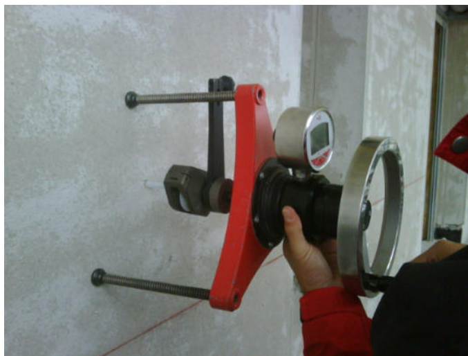
Prova di strappo su supporto con intonaco risanato
