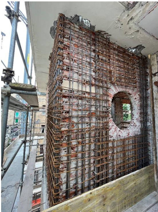
Vista di un setto in fase di esecuzione
