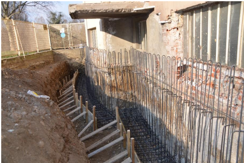
Vista delle nuove fondazioni in fase di esecuzione
