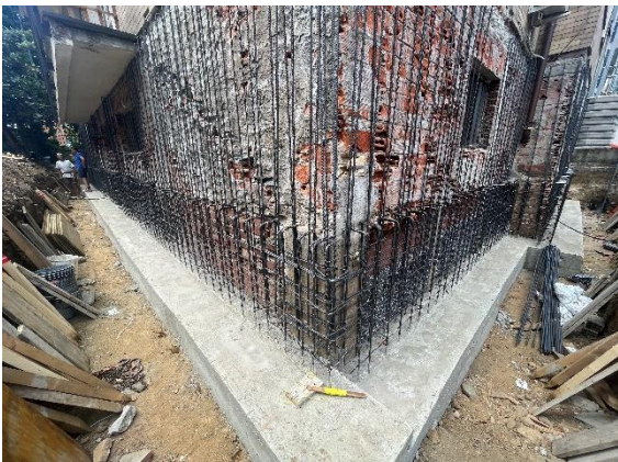
Vista delle nuove fondazioni in fase di esecuzione
