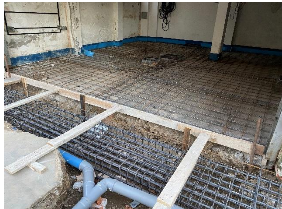
Vista delle nuove fondazioni in fase di esecuzione
