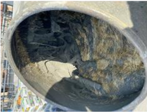
Impasto del calcestruzzo fibrorinforzato e fase di esecuzione del primer/getto
